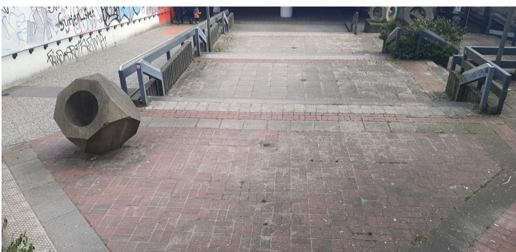
Die Rampe wird verbreitert um einen barrierearmen Zugang zu ermöglichen.
